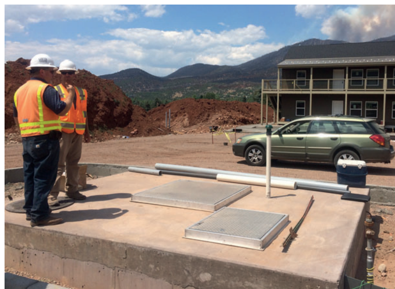
Fig. 6: También se hormigonó una cubierta con un espesor de aproximadamente 25 cm con escotillas de entrada.
