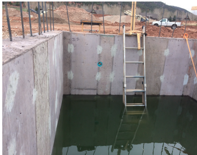
Figura 8: Ya la primera prueba hidrostática arrojó un excelente resultado.
