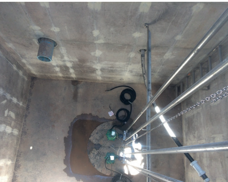
Figura 7: Vista desde arriba de la nueva estación de bombeo de hormigón in situ, un elemento clave de la infraestructura de aguas residuales para la ampliación del exclusivo Club Fork en Basalt, en el estado de Colorado, EE.UU.
